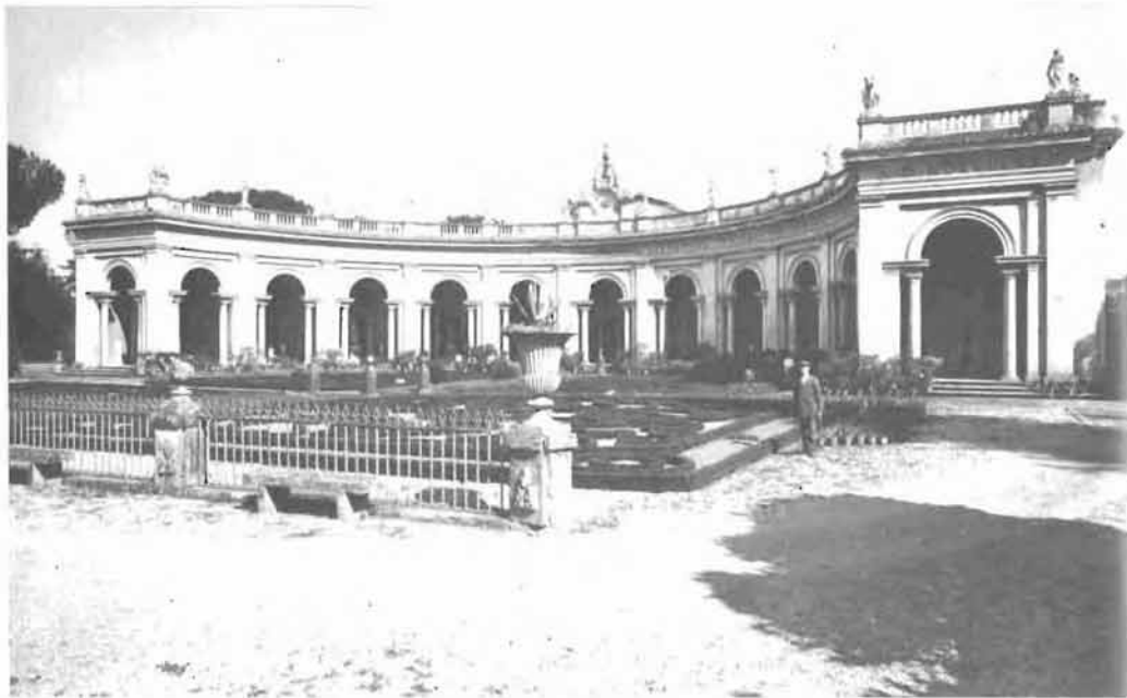
132. Κάρλο Μαρκιόνι, Περίπτερο της Βίλας Άλμπανι, Ρώμη, 1743-63. Η γνωστή συλλογή κλασικών αρχαιοτήτων που στέγαζε η Βίλα Άλμπανι δείχνει να έχει επηρεάσει εδώ τον αρχιτέκτονα, ωθώντας τον στην υιοθέτηση νεοκλασικού ύφους.
